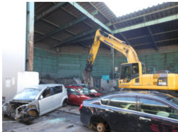
巨大な重機が車から重要部品をつまみだす（会宝産業の解体工場）
